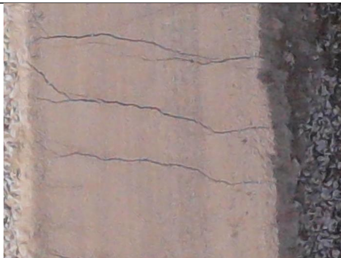
Foto 5- Rachaduras constatadas por imagem de drone na região da Mina 18
